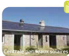
Centrale panneaux solaires
